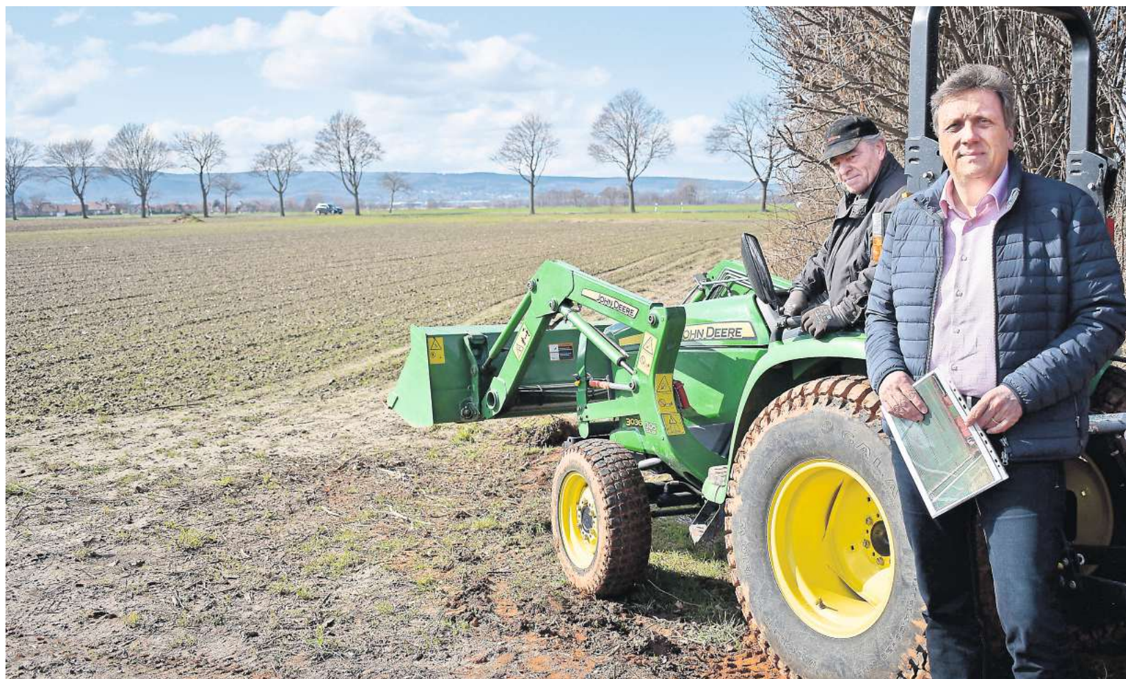
Wolfgang Grosam, der zweite Vorsitzende des TV Jahn Leveste (rechts), ist froh, dass die ersten Vorarbeiten für den neuen Fußballplatz begonnen haben. Vereinsmitglied Erhard Jakob hilft in Eigenleistung beim Planieren der Zuwegung. FOTO: SARAH ISTREFAJ
